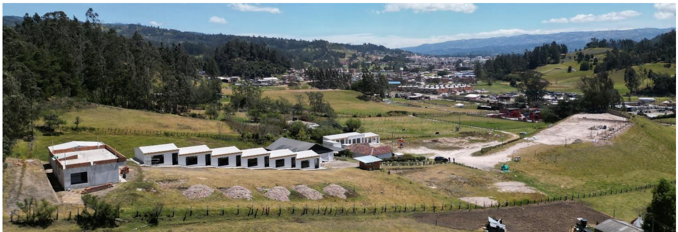
Iglesia Casa del Padre y Escuela Cristo es Rey – Hope City Church Project 2025
